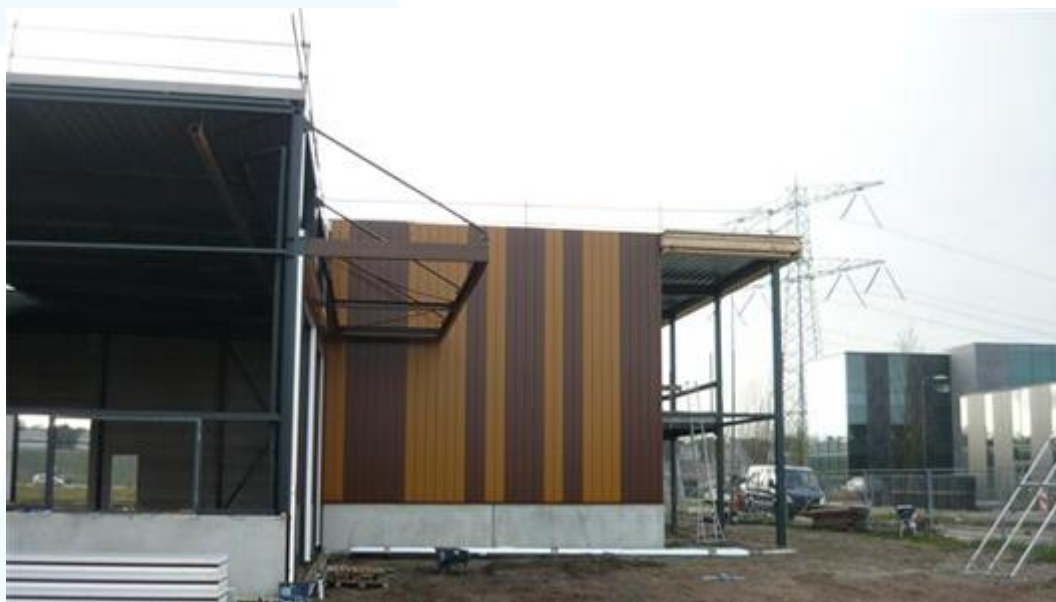
Bouwplaats A-booth Oostzaan
